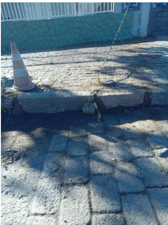
Foto 56 – Meio Fio Refeito
