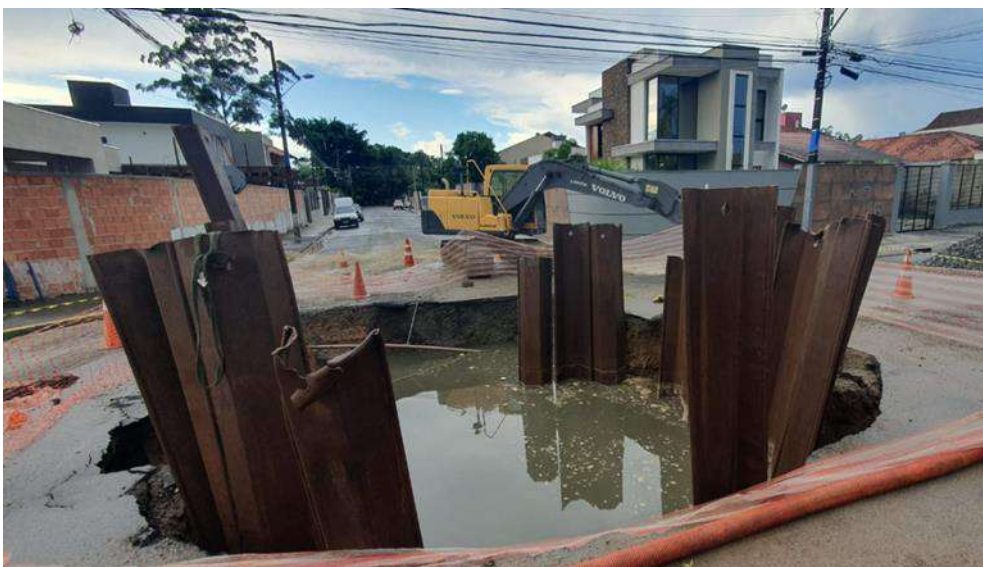
Foto 84 – Instalação de Proteções Laterais
