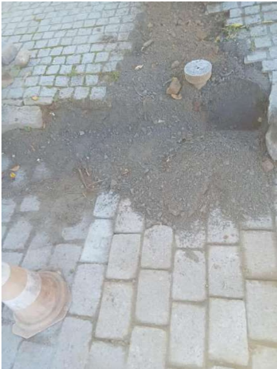
Foto 55 – Necessidade de Recomposição do Meio Fio
