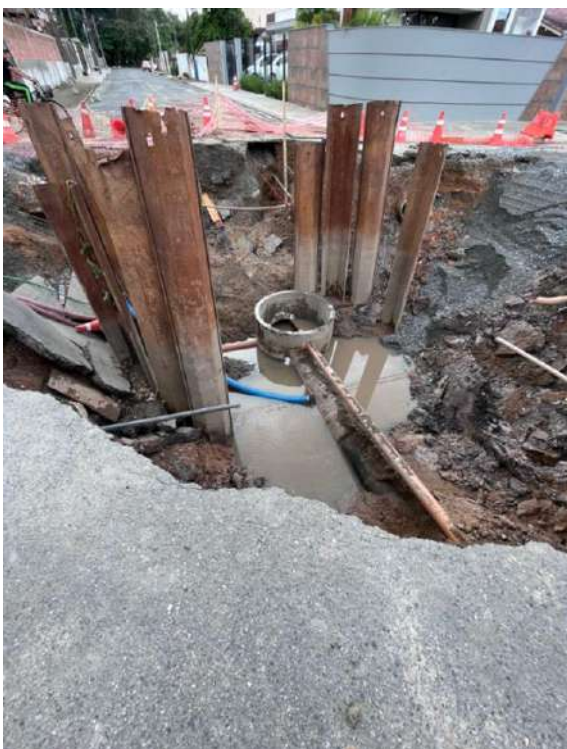
Foto 86 – Reparo do Poço de Visita
