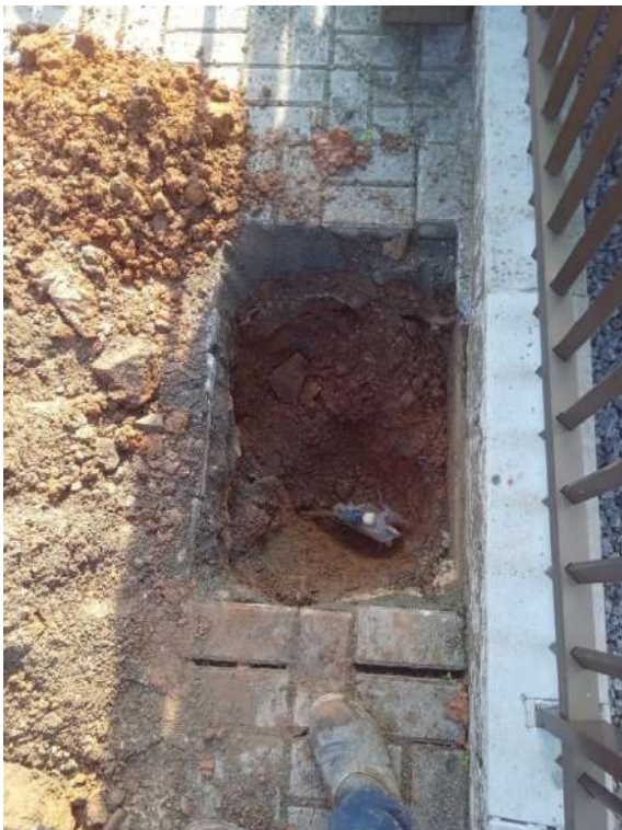
Foto 29 – Corte no Ramal Efetuado
