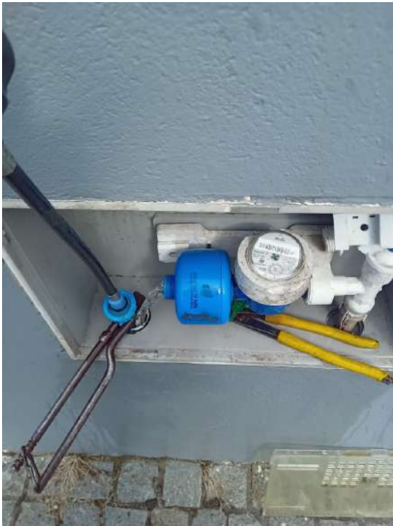
Foto 31 – Processo de Interrupção no Ramal
