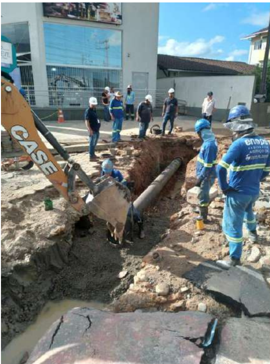
Foto 82 – Trabalhos Emergências de Reparo
