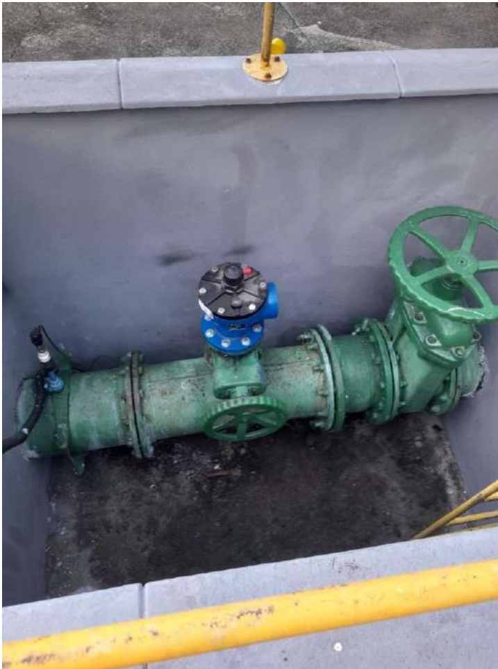
Foto 79 – Instalação de Ventosas
