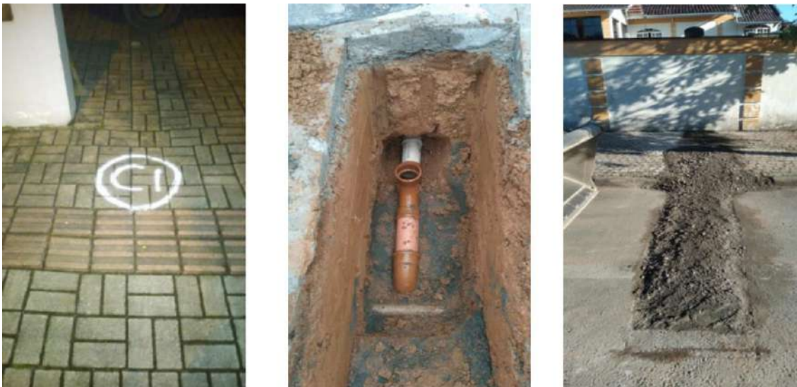
Foto 74 – Serviços de Ligação de Ramal de Esgoto
