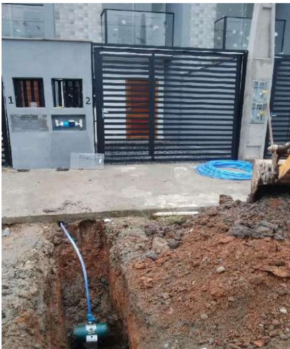
Foto 38 – Instalação Finalizada, faltando cobrir acesso e pavimentar
