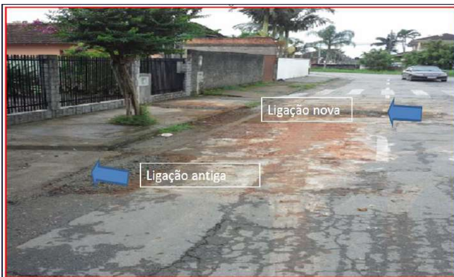
Foto 59 – Serviço de Deslocamento de Ramal e Eliminação de By-Pass
