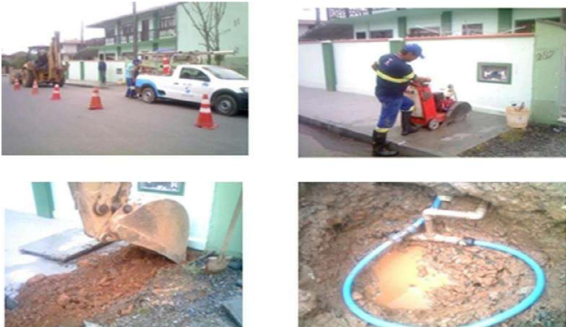
Foto 58 – Trabalhos de Eliminação de Derivação de Ramal (By-Pass)
