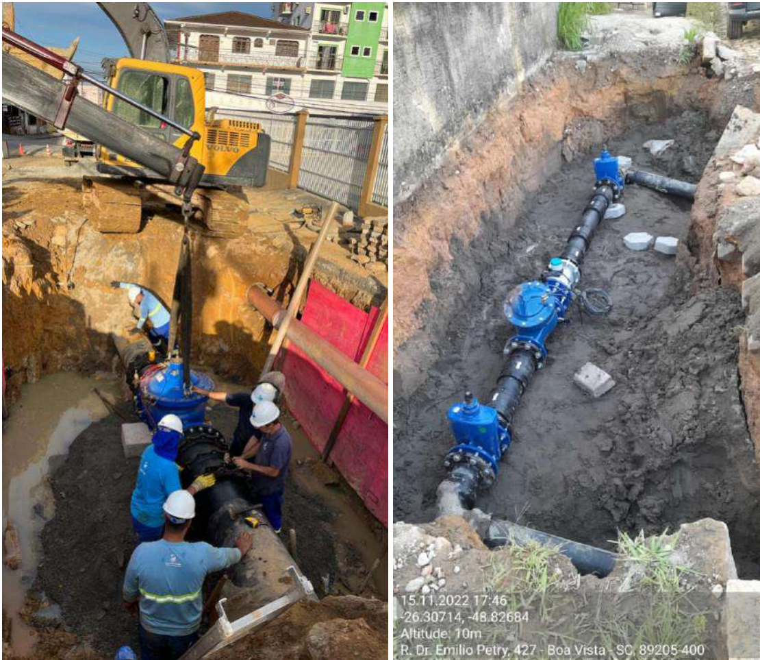
Foto 76 – Instalação de Macromedidores e Válvulas Redutoras de Pressão
