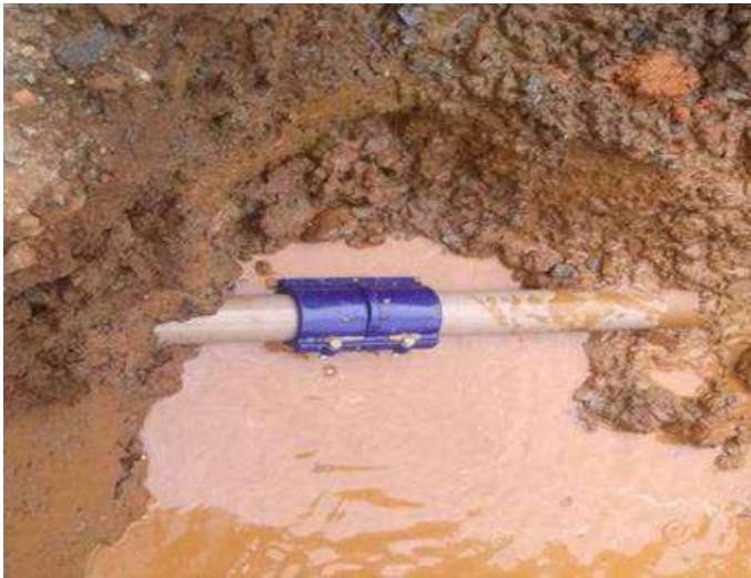
Foto 64 – Corte na rede com aplicação de colar cego
