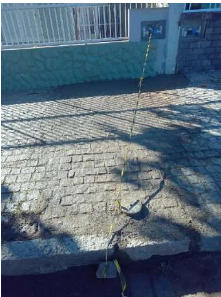
Foto 49 – Serviço em Piso Especial Concluído
