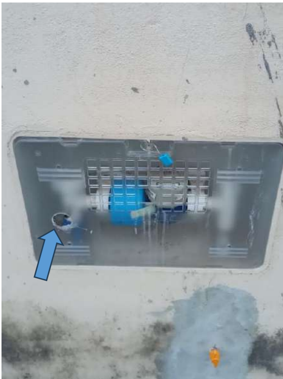
Foto 15 – Tapa da Caixa Padrão com o Furo
