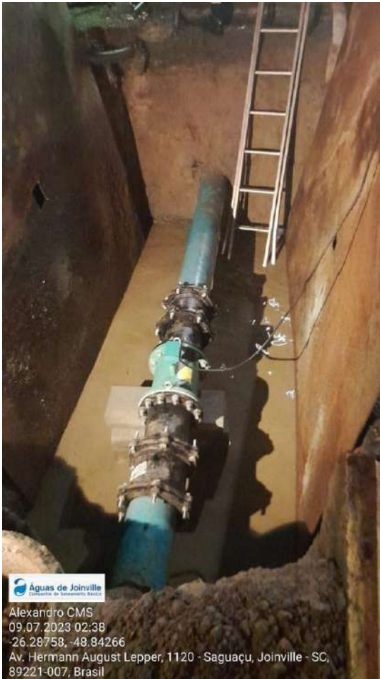
Foto 77 – Instalação de Macromedidores e Válvulas de Retenção
