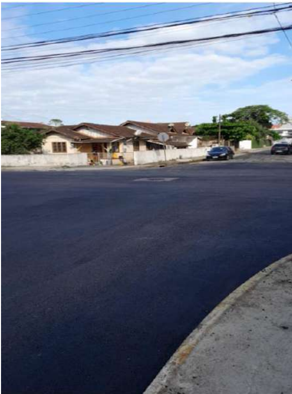
Foto 88 – Trabalhos de Pavimentação
