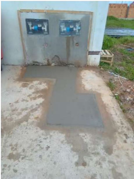
Foto 52 – Serviço em Cimento Finalizado
