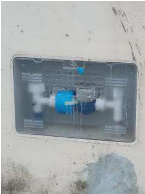
Foto 14 – Tampa da Caixa Padrão sem Furo
