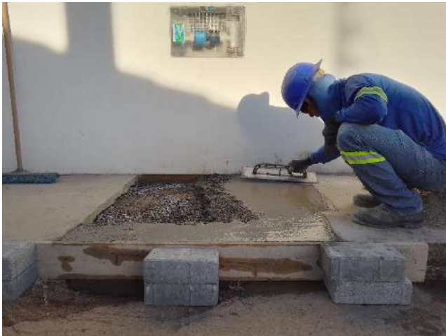
Foto 50 – Serviços em Concreto
