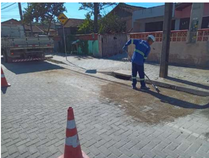
Foto 47 – Trabalhos de Recolocação em Paver Concluídos
