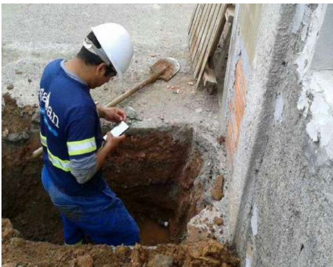
Foto 62 – Corte ramal em kit cavalete
