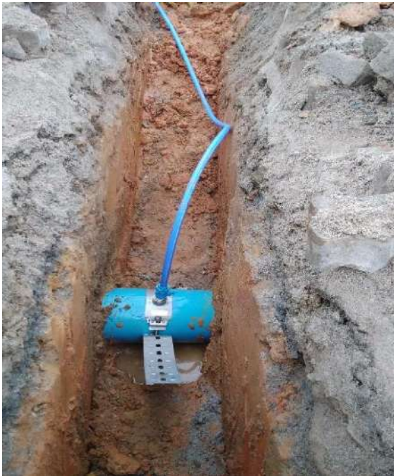
Foto 37 – Instalação de Ligação de Água (redes acima de 100mm)
