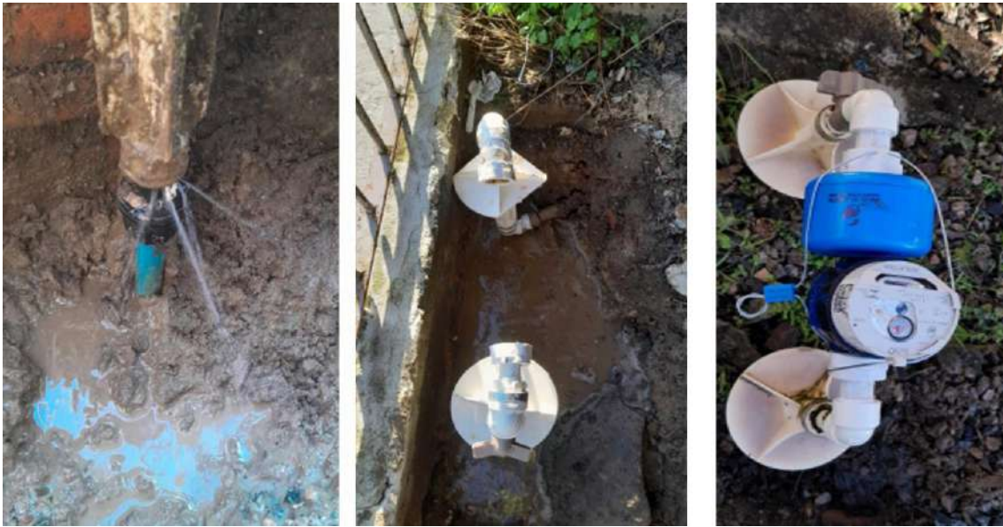
Foto 72 – Serviços de Conserto de Vazamento em Cavaletes
