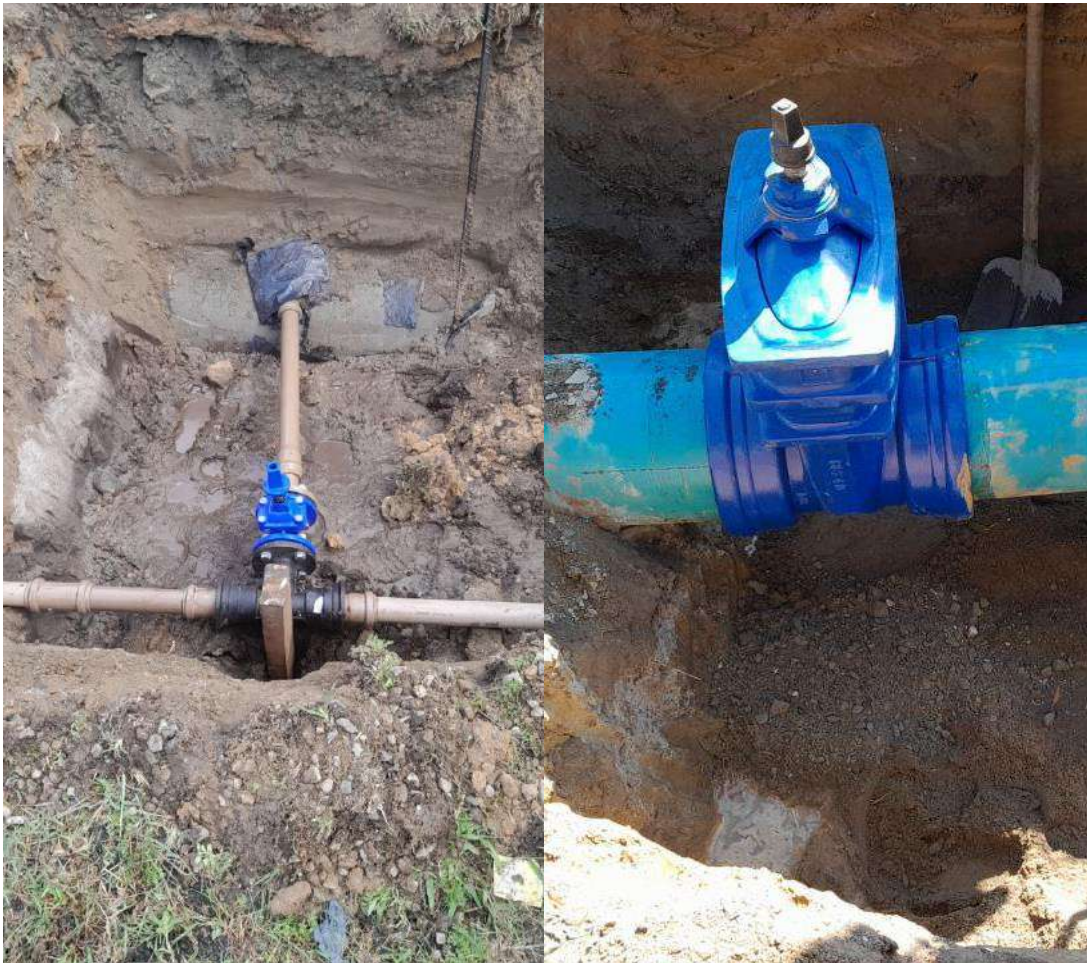
Foto 78 - Instalação de Registros de Manobra
