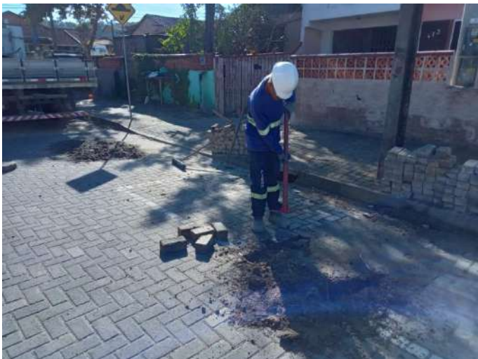
Foto 46 – Trabalho de Repavimentação em Paver
