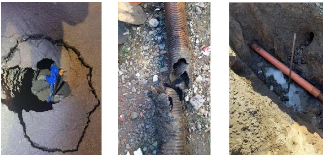
Foto 73 – Serviços de Conserto em Redes de Esgoto
